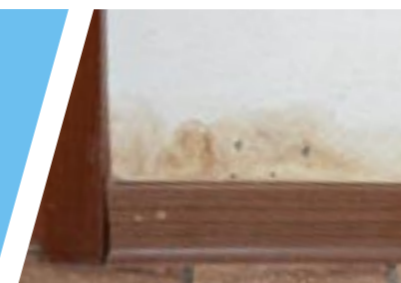
Oben, rechts und unten: Wasserschäden durch Leckagen an wasserführenden Leitungen
