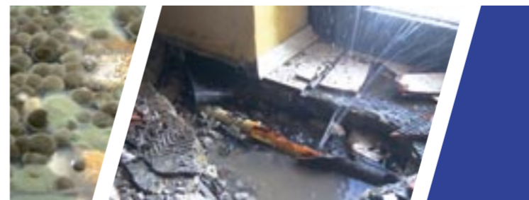
Oben, rechts und unten: Wasserschäden durch Leckagen an wasserführenden Leitungen
